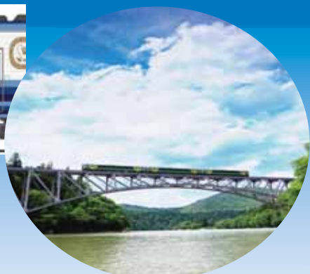
第一只見川橋梁
